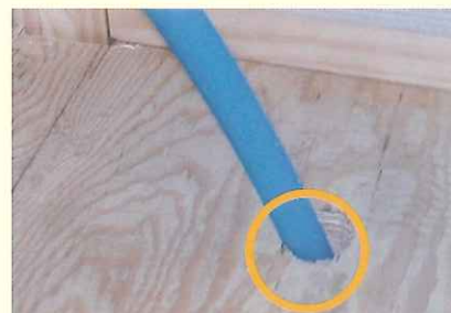
床下から引き上げる際も、管表面に傷が発生しません。
