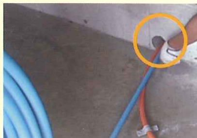
間仕切り基礎貫通の際、管表面に傷が発生しません。
