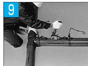
すばやく、挿入機のレバーを操作して接合します。接合後はすぐに取外さず、しばらく保持してください。
