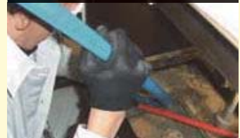
狭い開口からの通管施工状況
