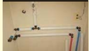
配管化粧カバーでの施工事例
