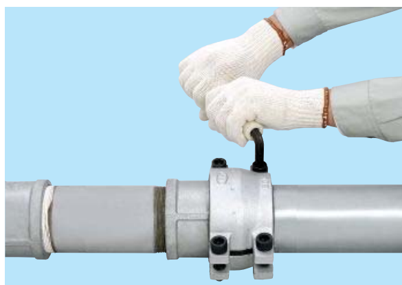
■パイプハンドルを使用しての装着作業
