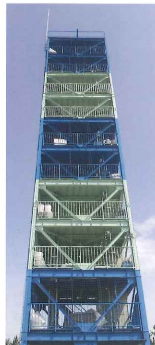
10階規模 排水試験タワー (埼玉県 秩父工場内)
